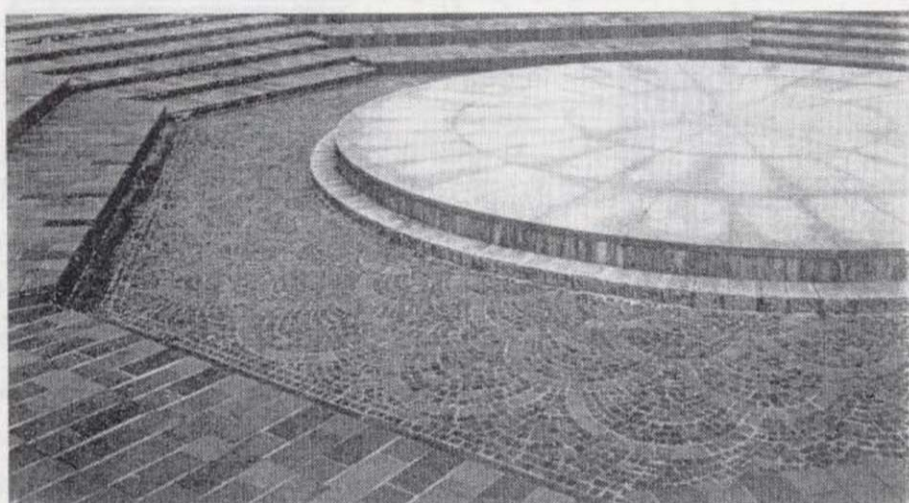
Foto 3.—Suelo de plaza que combina adoquinado en curvas con losas encuadradas.
